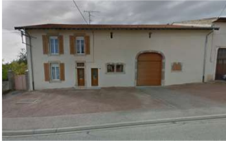
13. BA : Façades, 9-10 rue du Général Mathis
