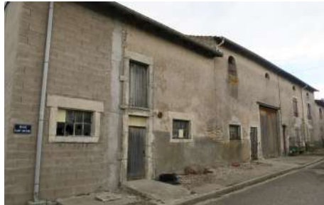
5. BA : Façades, 90 rue Saint-Antoine
