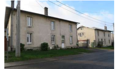
M. BR : Façades, 42-44-46 Grande Rue
