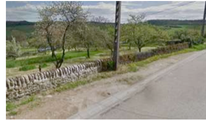
j3. Mur en pierre, rue de la Paix
