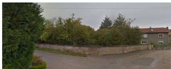
e5. Muret, rue du Maréchal Foch
