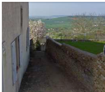
e1. Mur, 7 rue Saint Jean
