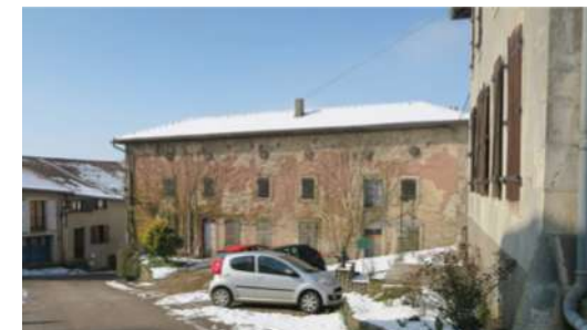
3. BA : 8 rue Saint Charles Façade remarquable dans sa composition
