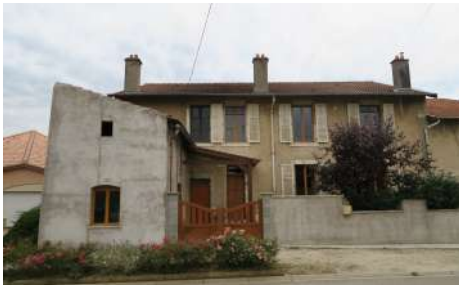
F. BR : Façade, 4 rue de Haraucourt
