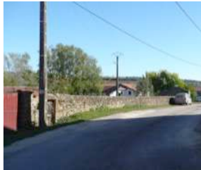
j1. Mur en pierre, rue de la Cure
