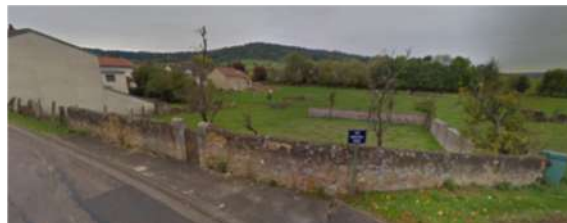
e2. Muret, rue du Maréchal Foch
