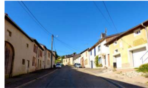
D. Alignement des façades rue du gen. Leclerc
