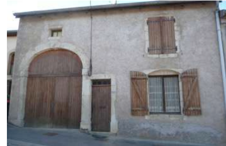
7. BA : Ferme, 26 rue du gen. Leclerc
