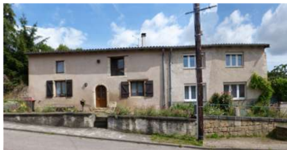
1. BA : Habitation, 14 rue Jules Ferry : Ancienne maison de vigneron
