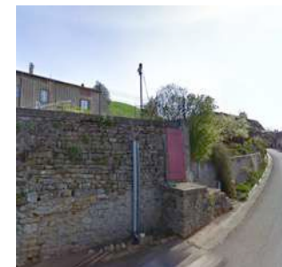
e3. Mur, rue Saint Jean
