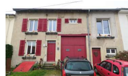
E. BR : Façade, 18 Grande Rue
