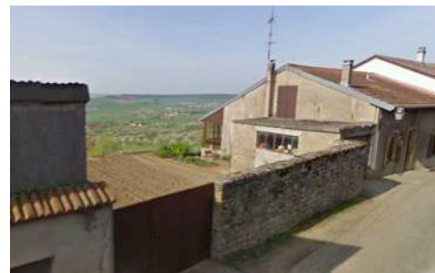
e2. Mur, 17 rue Saint Jean
