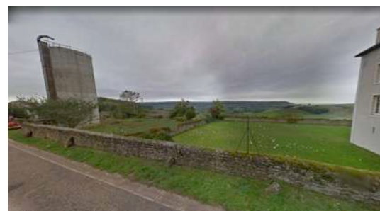
e16. Mur, rue Saint Charles
