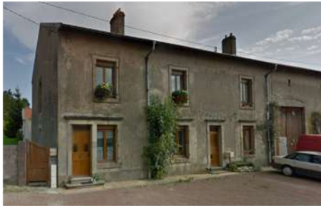
5. BA : Façades, 31-33 rue du Général Mathis
