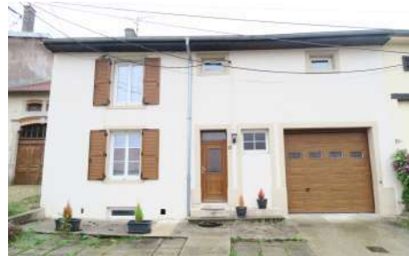
G. BR : Façade, 22 Grande Rue
