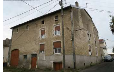
H. BA : Façade, 64 rue de l'Eglise
