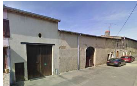
A. BA : Façades, 1-5-7 rue de l'Eglise
