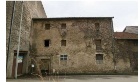
D. BA : Ancien château, rue de Réméréville
