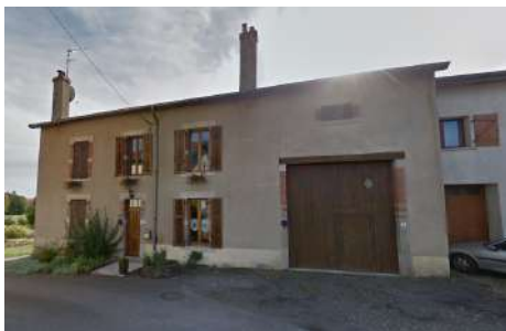
L. BA : Façade, 8 rue de Lorraine
