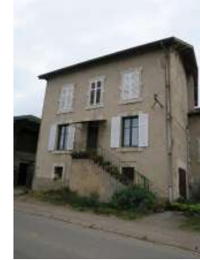
C. BA : Façade, 1 rue de la Libération
