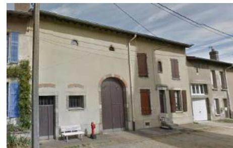
7. BA : Façade, 2 rue du Port
