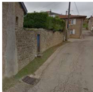
e8. Mur, rue Saint Charles
