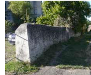
j4. Mur en pierre, derrière l'église
