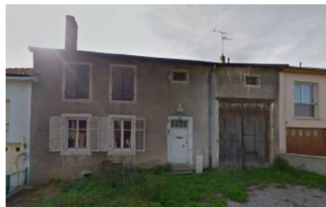
2. BA : Façade, 16 Grande Rue
