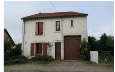
D. BR : Façade, 15 rue du Docteur Grandjean
