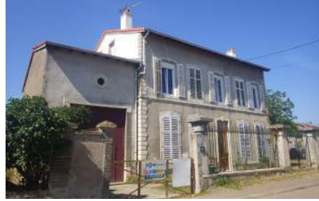
2. BA : Façade, 3 route de Moncel
