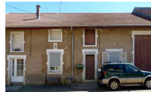
D. BR : Habitation, 8 rue du Château
