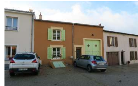
P. BA : Façade, 54 Grande Rue
