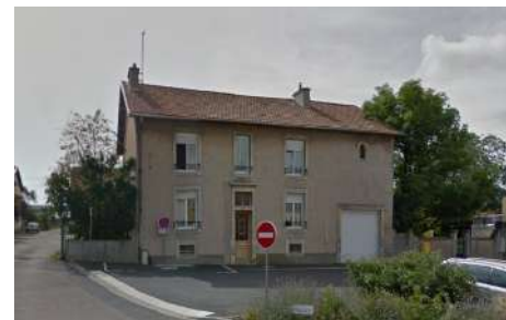
3. BR : Façade, 13 rue du Port
