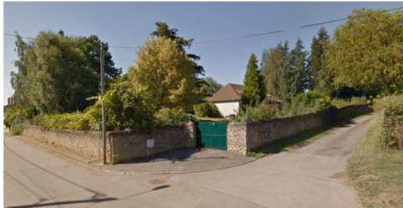
c1. Mur en pierre, rue Louis Pasteur et rue au Château
