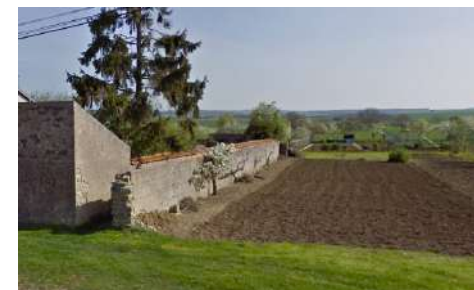
e. Muret, rue du Général Lambert
