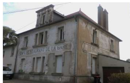
8. BR : Façade bâtiment annexe ancienne gare, 45 rue de l'Ancienne Gare
