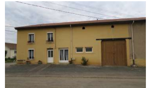
D. BR : Façade, 10 rue de l'Eglise
