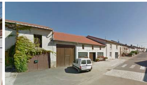
Q. Alignement de façades rue Charles de Gaulle (côté impairs)
