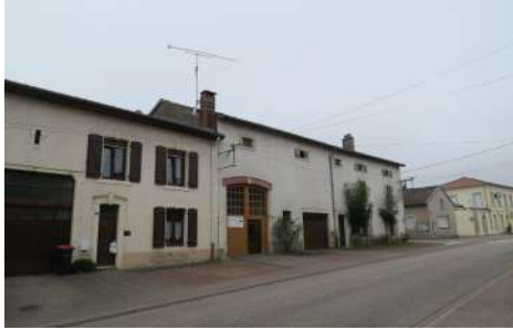
I. BA : Façade, 12 rue du Général Mathis
