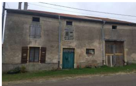
G. BA : Façade, 20 rue du Chaud Four
