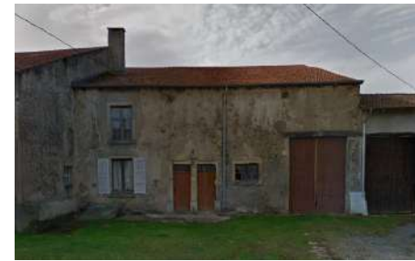
3. BA : Façade, 11 rue du Chaud Four
