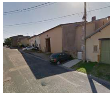
P. Alignement de façades rue Charles de Gaulle (côté pairs)
