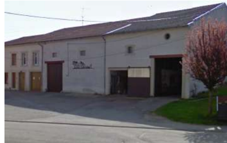
B. BA : Façade, 2 rue de l'Eglise
