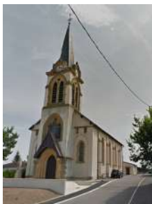
1. BR : Eglise du XVIII ème siècle, rue de l'Eglise
