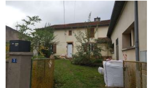
E. BR : Façade, 3 rue Damain la ville
