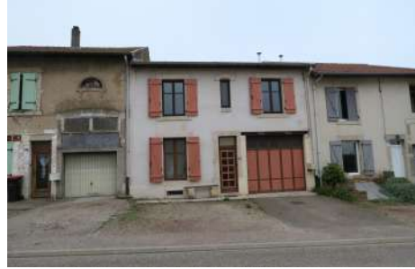
J. BR : Façade, 21 rue du Général Mathis
