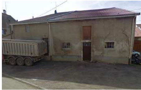
G. BA : Façade, 67 rue de l'Eglise
