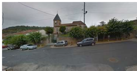
p. Aménagement paysagé, rue du château
