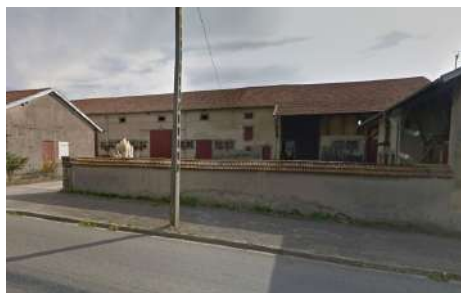
A. BA : Façade, 18 rue de Château Salins
