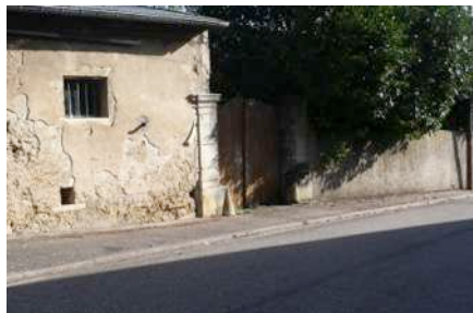
4. BA : Portail et muret, rue du maréchal Lyautey
