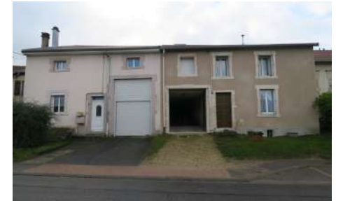
I. BR : Façades, 26-28 Grande Rue
