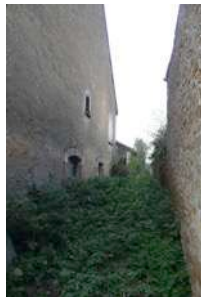
d1. Mur en pierre, 20 rue du gen. de Gaulle
