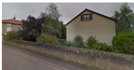
e4. Muret, rue du Maréchal Foch
