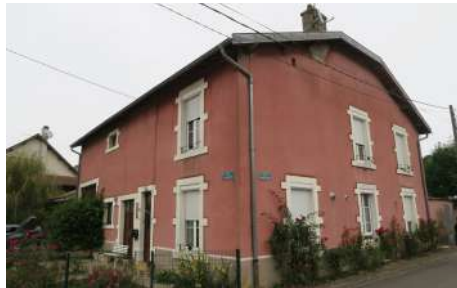
F. BR : Façade, 1 place de la Fontaine
