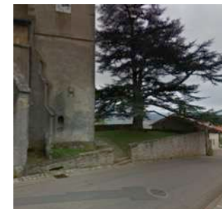
e6. Mur, rue Saint Jean
