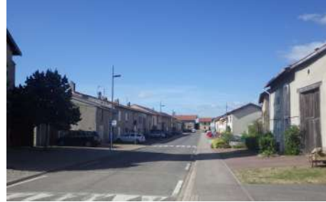
C. Alignement de façades, rue Haute
