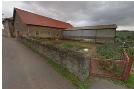
d2. Mur en pierre, ruelle Ferrée
