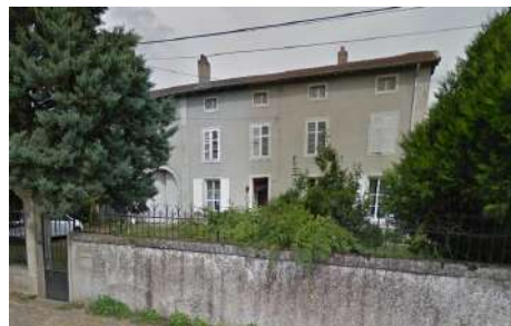
2. BR : Façade, 62 rue du Port
