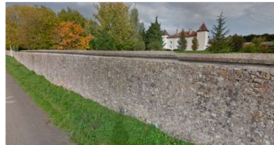
G. Mur d'enceinte rue Camille Bailly
