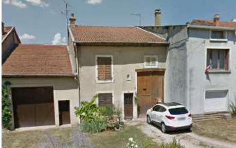
5. BA : Façade, 25 Grande Rue
