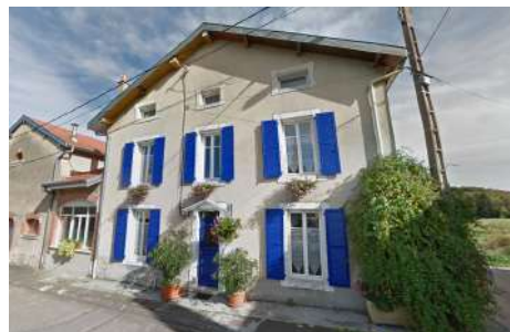
M. BA : Façade, 12 rue de Lorraine
